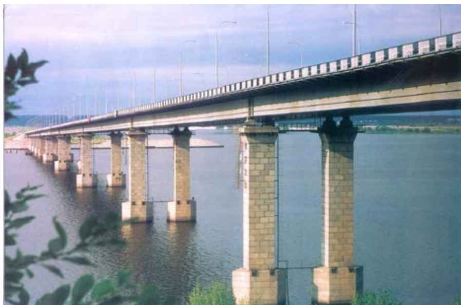
Мост через реку Волга на км 777+073 автодороги М-7 «Волга» от Москвы через Владимир, Н. Новгород, Казань до Уфы в Республике Татарстан
