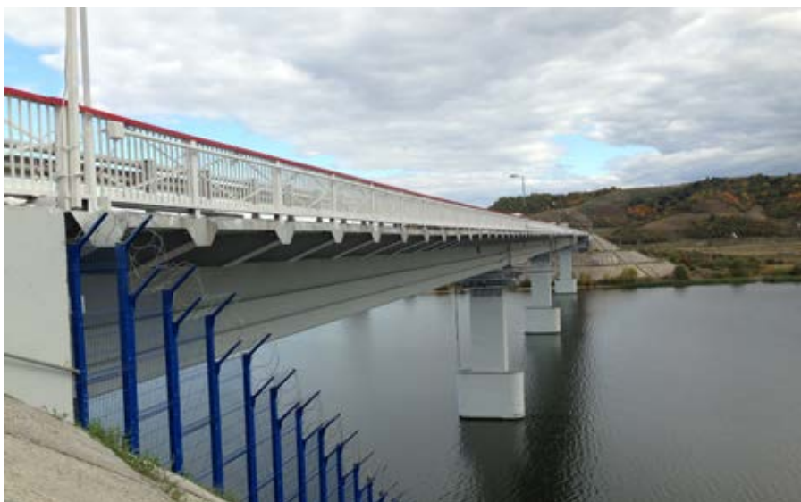
Мост через реку Свияга на км 757+185 (75 7+584) автомобильной дороги М-7 «Волга» от Москвы через Владимир, Нижний Новгород, Казань до Уфы в Республике Татарстан
