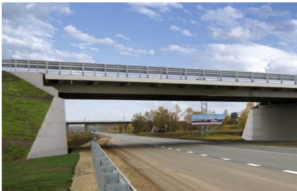
Реконструкция автодороги Елабуга — Ижевск — Ново-Менделеевский химический завод в Менделеевском районе РТ
